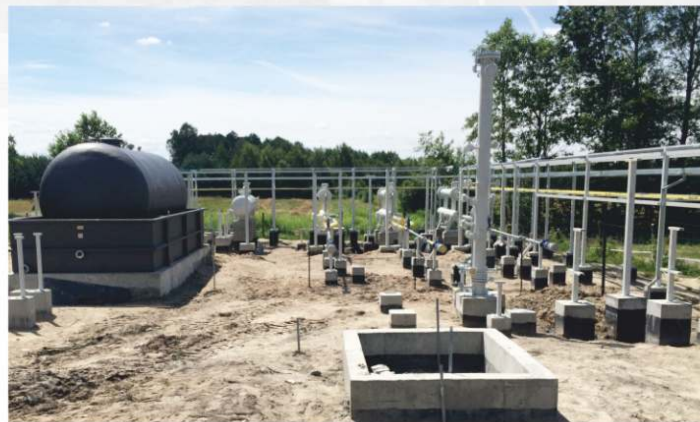
fundamenty wraz z podporami
