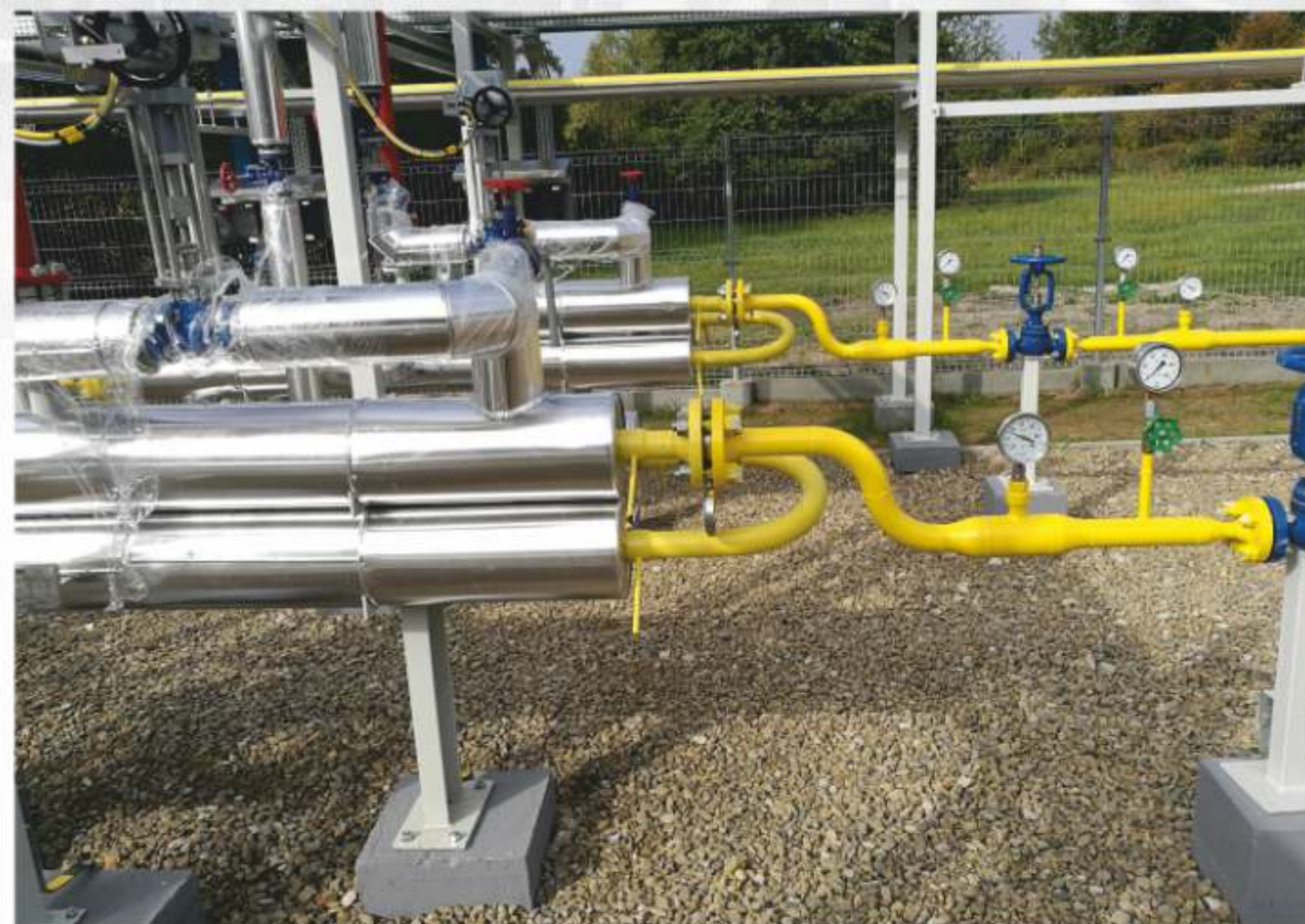
węzły redukcyjno-pomiarowe
